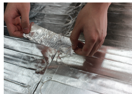
3.AF-MAT拼接处每隔半米黏贴纯铝箔胶带
