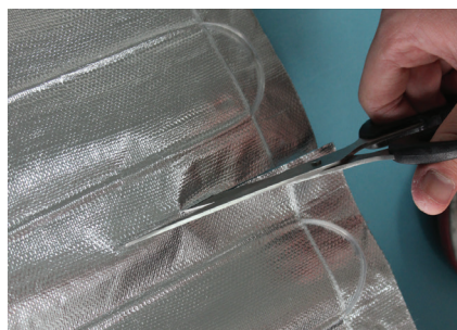
2.据室内铺设区域进行裁切(不可破坏电缆)
